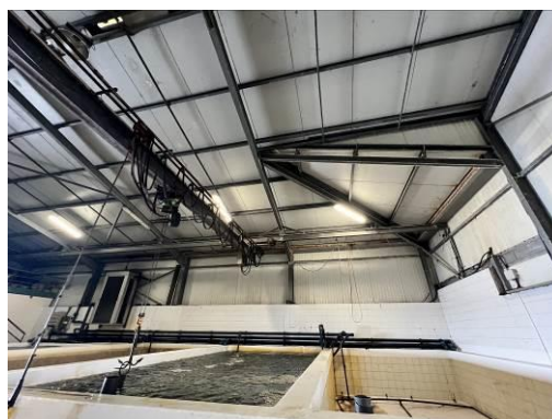
Charpente métallique en bon état général
