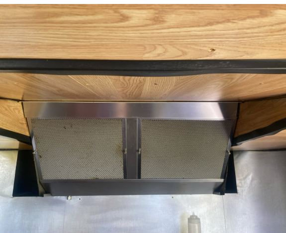
Hotte aspirante bon état
