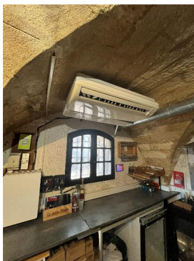
Système de climatisation au plafond
